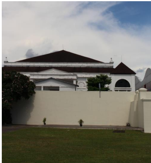
Gambar 7. Dinding Keliling Benteng (Sumber: Dokumentasi Penulis, 2024)
